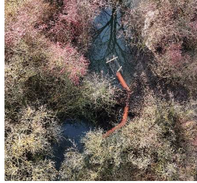
Abbildung 13 Einbau Biberdammdrainage in initiierten Biberdamm an der Gramme in Erfurt-Wallichen
