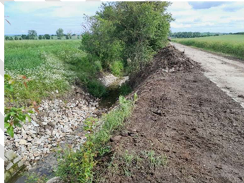
Abbildung 11 Sohlsicherung des Ringelgrabens in Witterda 2024
