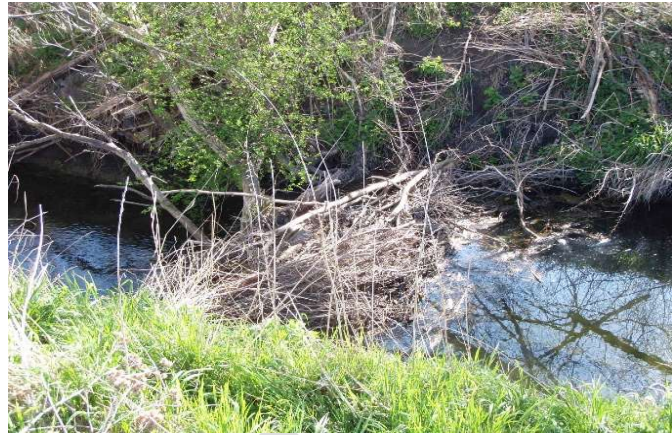
Abbildung 2 Beseitigung Schwemmgut aufgrund von Verklauung am Utzberger Bach
