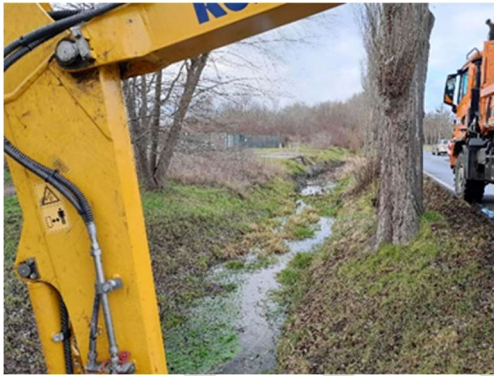
Abbildung 10 Sedimentberäumung der Lache in Erfurt - Stotternheim im Jahr 2023
