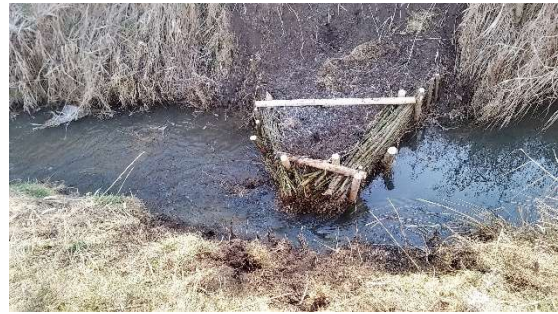
Abbildung 4 LP 10647: Einbau von Strömungslenkern am Gewässer Gramme als Maßnahme im GUP 2026
