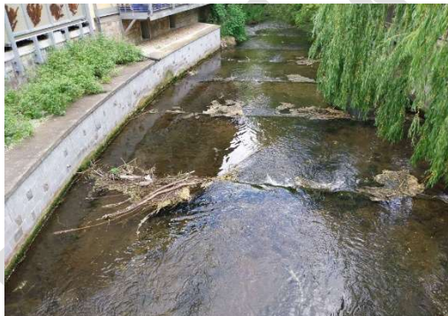
Abbildung 8 Beräumung Schwemmgut Sohlgleite in Erfurt Venedig links
